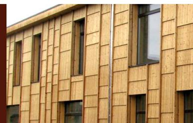
Les **Binderholz Thermo** sont des panneaux thermo-traités développés pour usage extérieur, tel que les constructions extérieures, les bardages, le mobilier d'extérieur. Le traitement thermique assure une haute durabilité contre les champignons et les insectes (EN 252 classe 2 - convient pour une utilisation en extérieur non traitée) et une grande stabilité dimensionnelle (travail du bois minimal).
