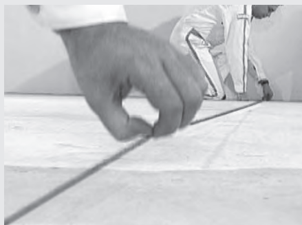
Tracé de l'axe des murs au cordeau ou au laser
