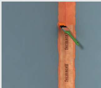
Fig. 19b : ... et appliquer immédiatement la Sous-couche de protection à l'eau
