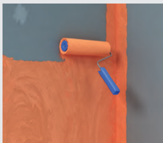
Fig. 23 : Appliquer la Sous-couche de protection à l'eau fermacell au rouleau (épaisseur totale \geq 0,5 mm).
