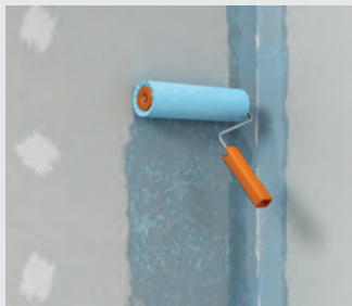
Fig. 18 : Appliquer la Couche de fond fermacell sur toute la surface
