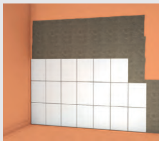
Fig. 24 : Les carreaux sont posés sur une fine couche de Mortier-colle flexible fermacell appliquée sur support étanche (protégeant contre une taux d'humidité de classe A).
